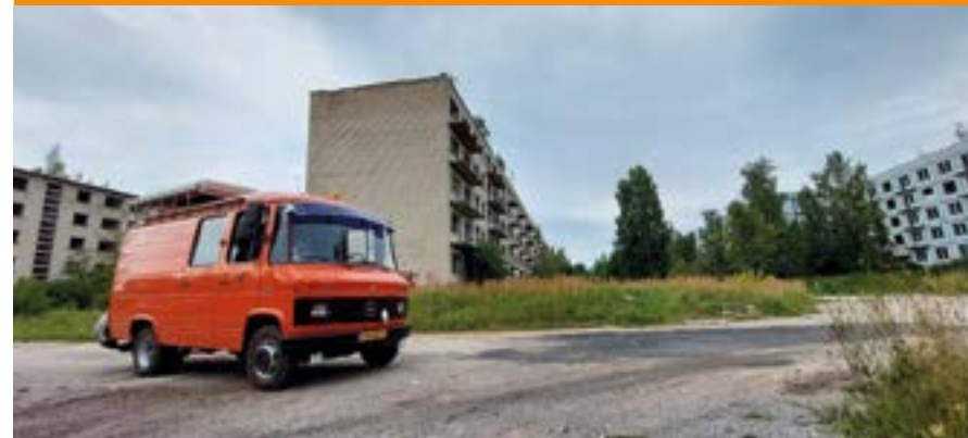
VENTSPILS 8 verpauperde flats
